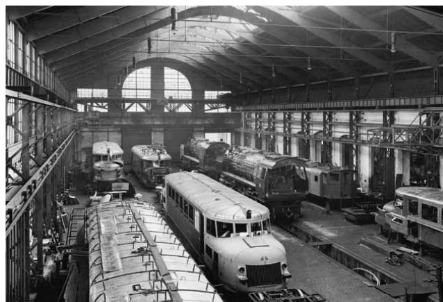
Die Montagehalle 1013 (heute: Lokstadt Halle Rapide) im Umbau, 1919. Foto: Winterthurer Bibliotheken
