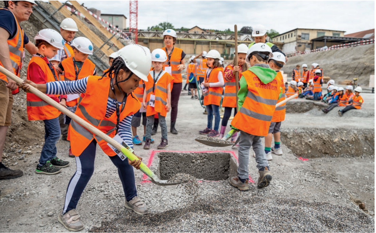
Im Rahmen des Langzeitprojekts «Raum schaffen» erleben Kinder aus dem Tössfeld die Lokstadt-Grossbaustelle und packen auch gleich mit an, hier bei der Grundsteinlegung. (Bild: Implenia)
